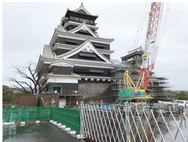
復旧工事中の熊本城。特別見学通路から撮影。
